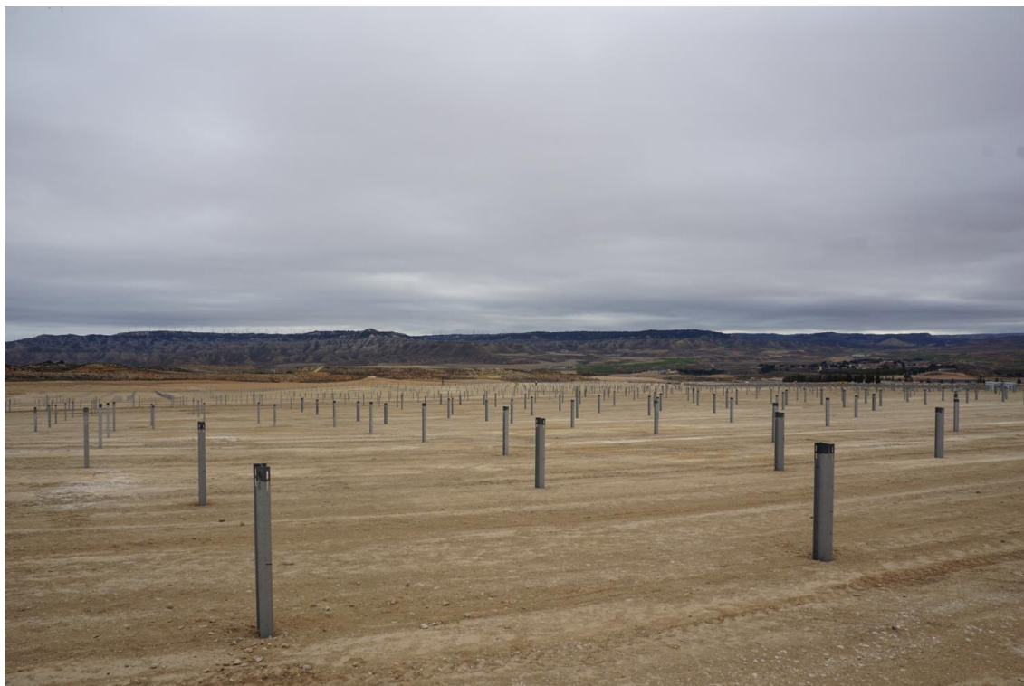
Figura 11 Vista general Plana de la Pena 1, finales de febrero
